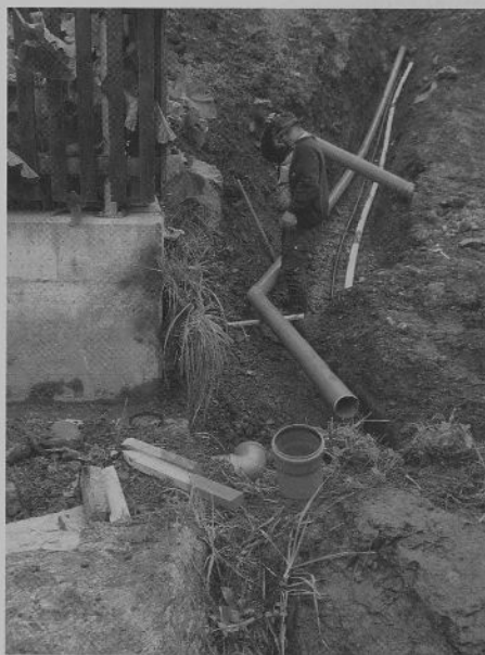
Einlegearbeiten Wasser- und Abwasserleitungen für Jubiläumsbrunnen Rossihubel.
