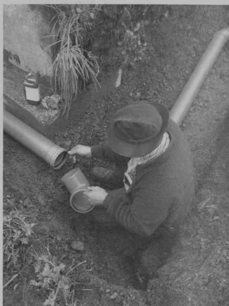
Einlegearbeiten Wasser- und Abwasserleitungen für Jubiläumsbrunnen Rossihubel.
