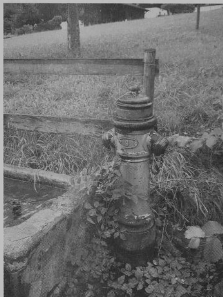
Hydrant 1904 beim Ziindli.
